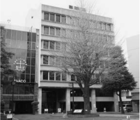
耐震・改修工事を待つ（本年 2 月撮影）
