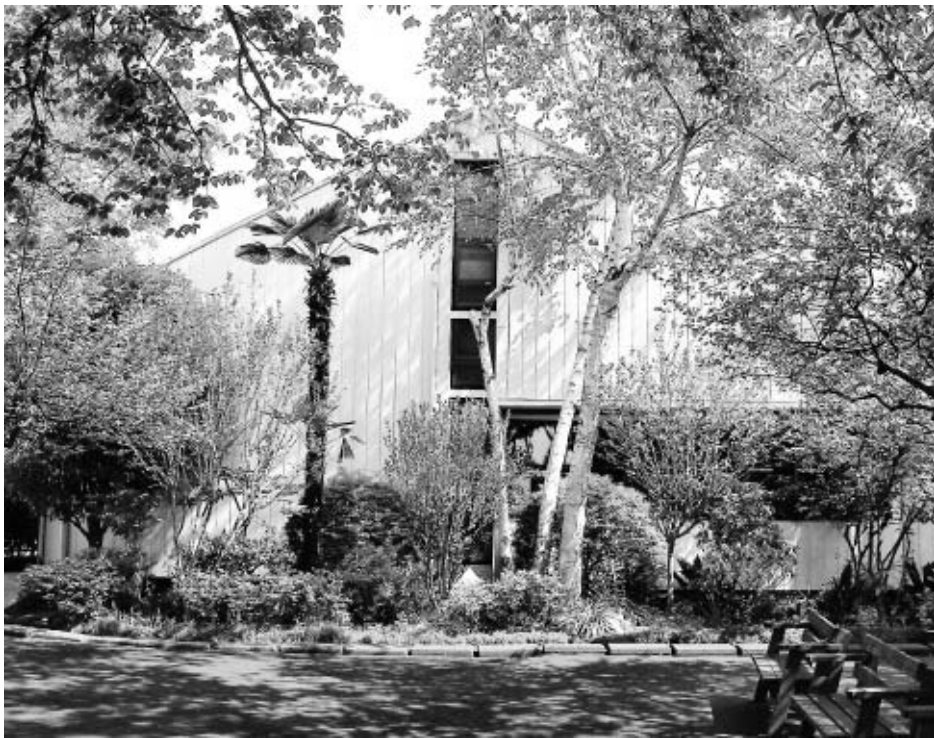
国分寺教会 (西東京教区・多摩地区)
