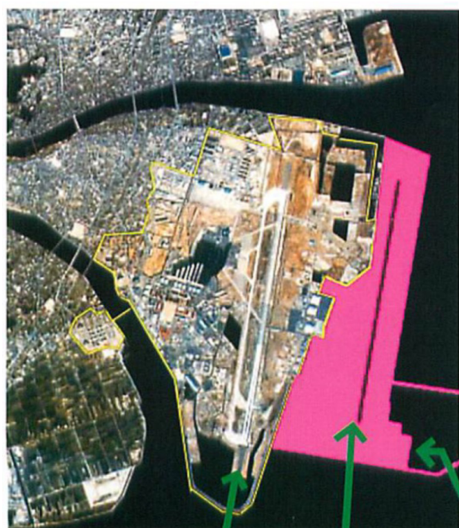
旧滑走路 新滑走路 大型岸壁
