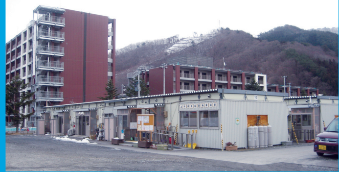
■上中島復興公営住宅(奥)と仮設住宅(手前)
