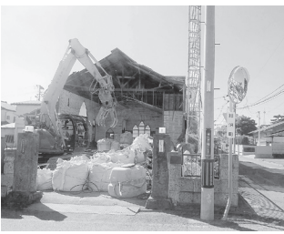
礼拝堂解体工事
