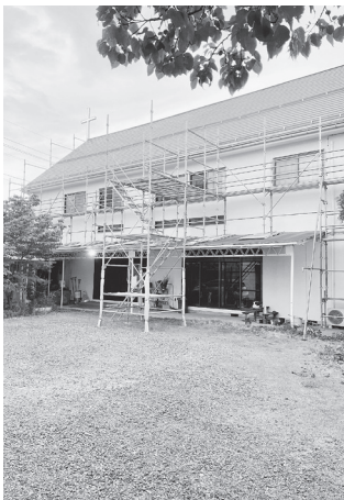
足場を組み、2階の外壁を補修
