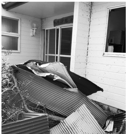
トタン屋根が集積、波浮教会
