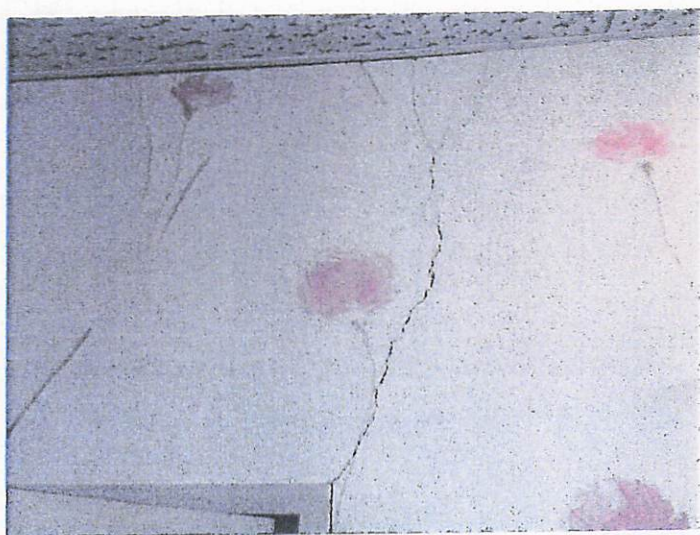
1Fホール 壁の亀裂の様子
