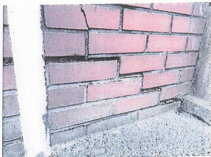
外部 花壇付近 断裂の様子
