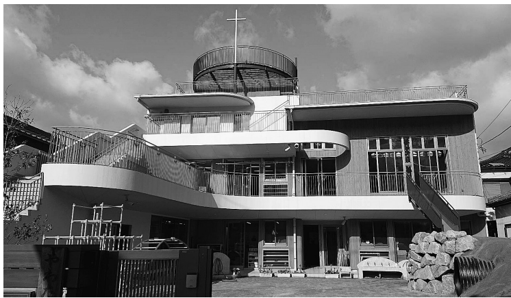
津波の避難所を設けた園舎
