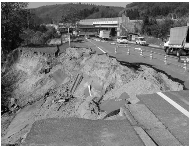
関越自動車道越後川口インターそばの崩落現場
