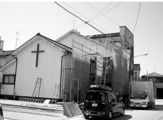
輪島教会会堂補修と牧師館改築の工事現場
